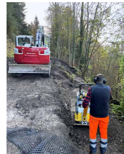
Sanierungsarbeiten an der Ischenstrasse.
