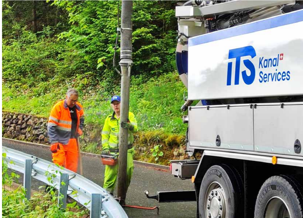
Reinigung Schlamm-sammler bei der Strassenentwässerung.
