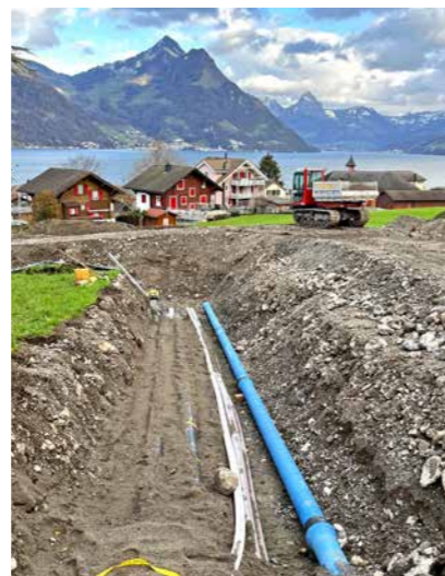
Der Graben für die Verlegung der neuen Fernwärmeleitungen wurde sogleich für Sanierungsarbeiten am Wasserleitungsnetz genutzt.
