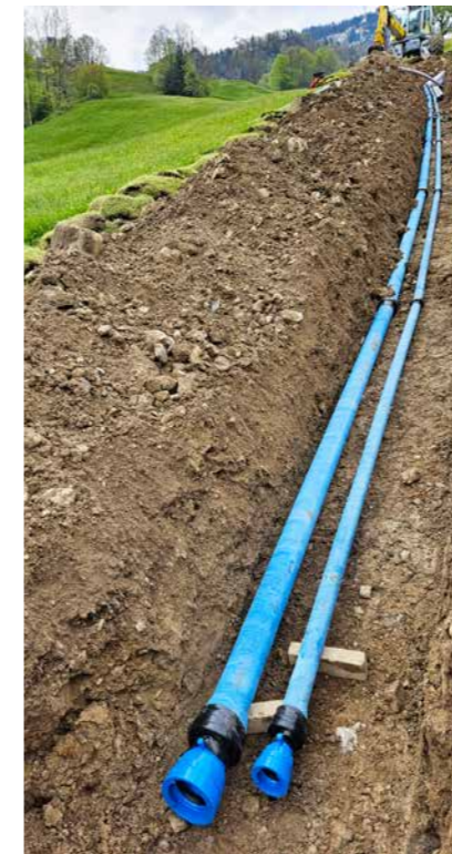
Verlegung der Druckleitung.
