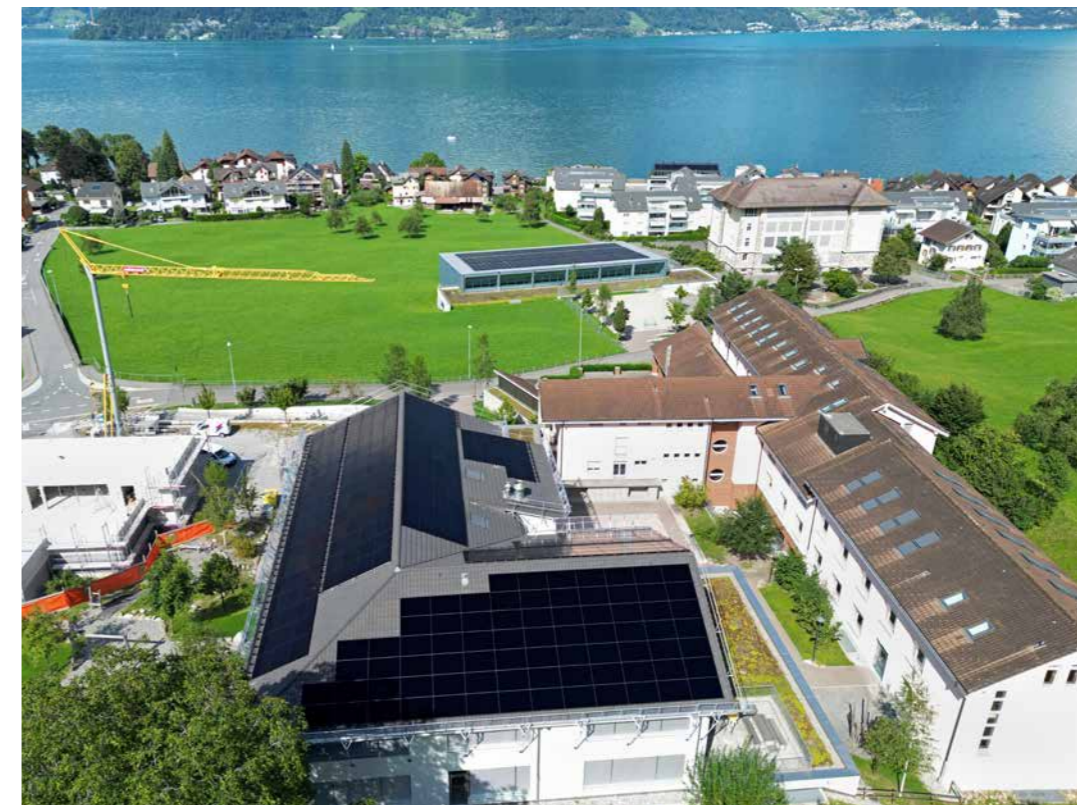
Photovoltaikanlage auf dem Unterstufenschulhaus in Beckenried. Im Hintergrund die Photovoltaikanlage auf der Turnhalle Isenringen.
