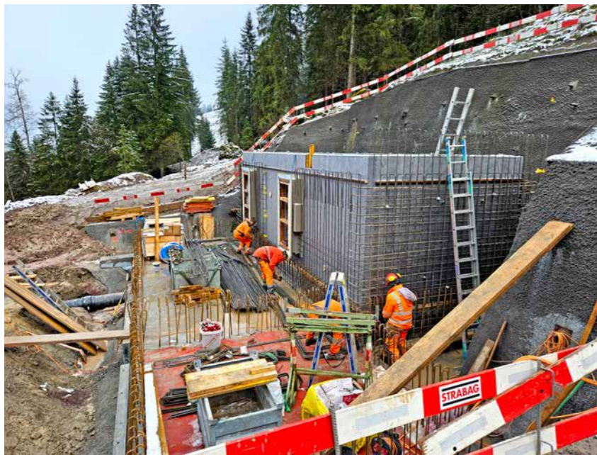
Rohbauarbeiten beim neuen Stufenpumpwerk mit Druckhaltebecken.
