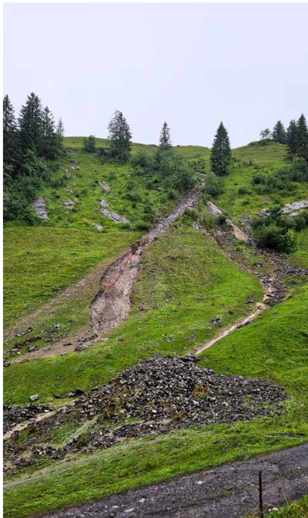
Beschädigung und Ausspülung der Stromkabelleitung durch einen Murgang.
