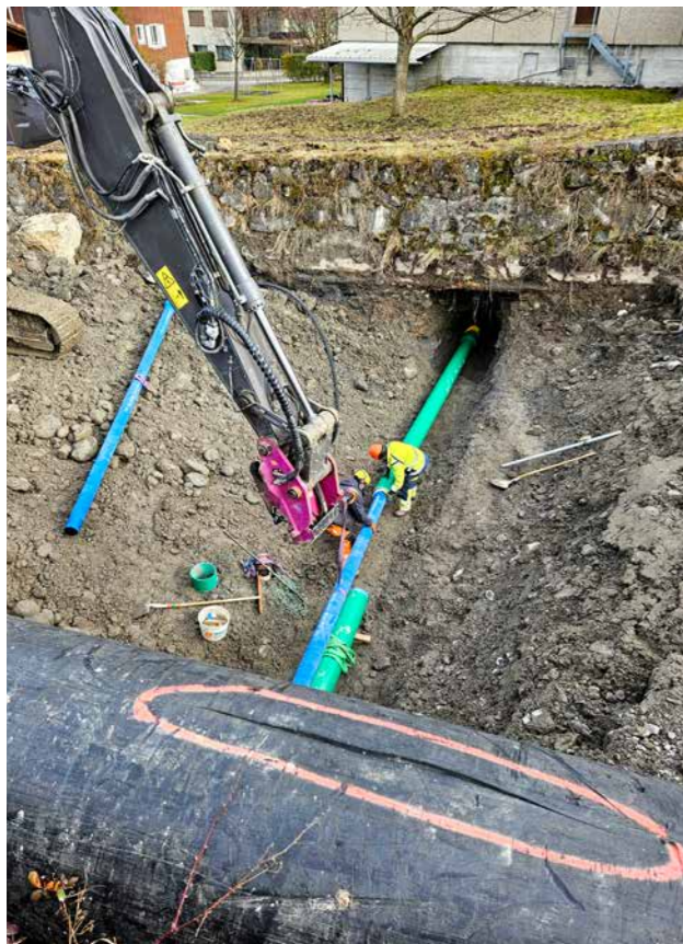
Für Sanierungsarbeiten am Wasserleitungsnetz wurde der Lielibach unterquert.
