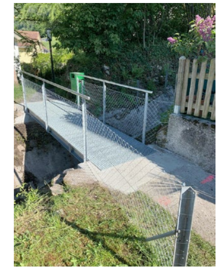
Fussbrücke über den Sumpfbach auf der Höhe Oberhostatt
