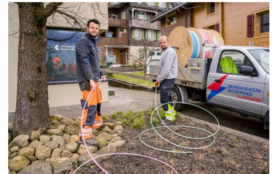
Robin Herger und Philippe Pereira beim Einziehen von Rohren für Glasfaserkabel
