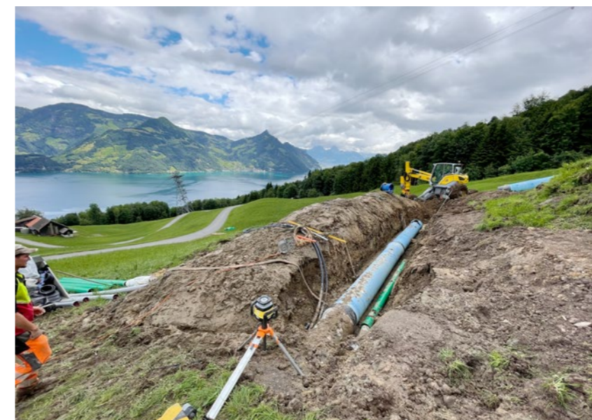
Rohrleitungsbau Hangleitung Lielibach-Napf
