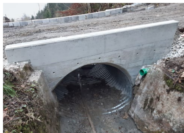
Die sanierte Dürrenbachbrücke
