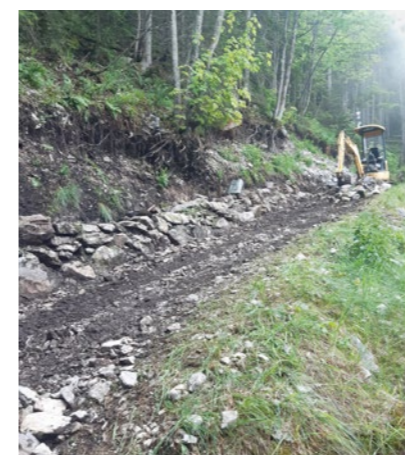
Arbeiten am Wanderweg Bärenfalle Bergplangge
