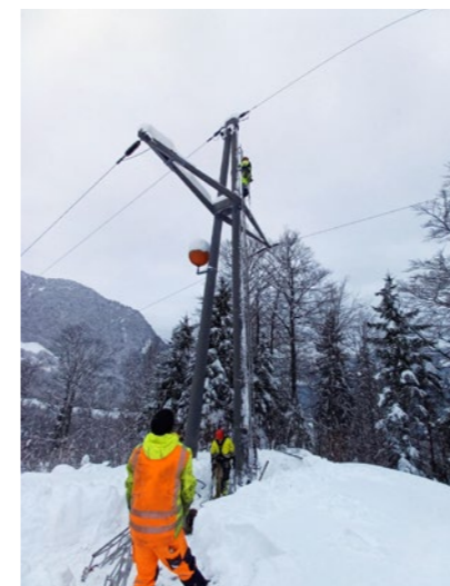
Reparatur der beschädigten Freileitung
