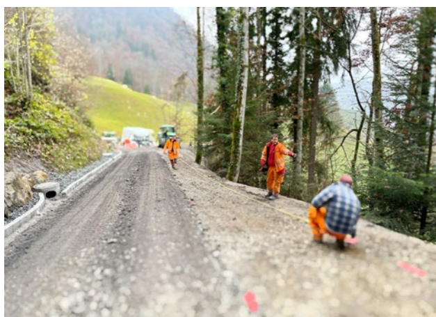
Sanierungsarbeiten an der Brunnistrasse
