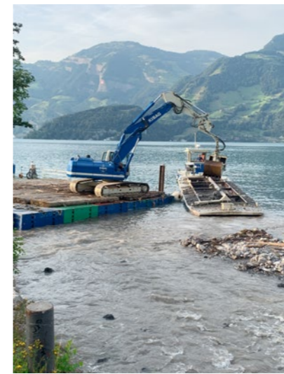
Räumung Bachdelta mit Ponton und Bagger
