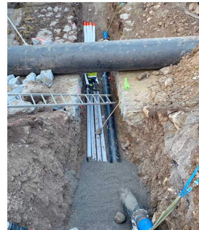
Querung des Träschlibachs im Rahmen der Bachsanierung
