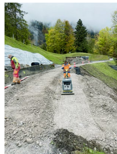
Sanierungsarbeiten an der Brunnistrasse
