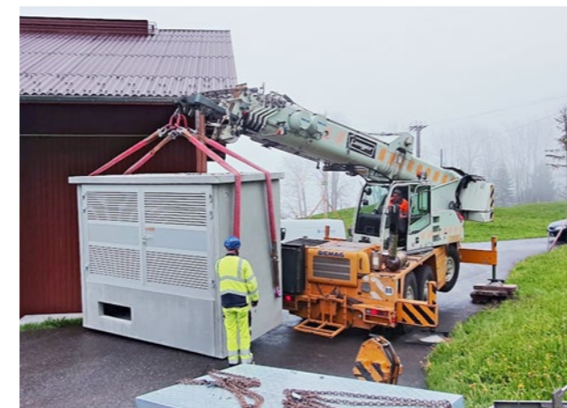
Montage der neuen Transformatorstation Ruotzen
