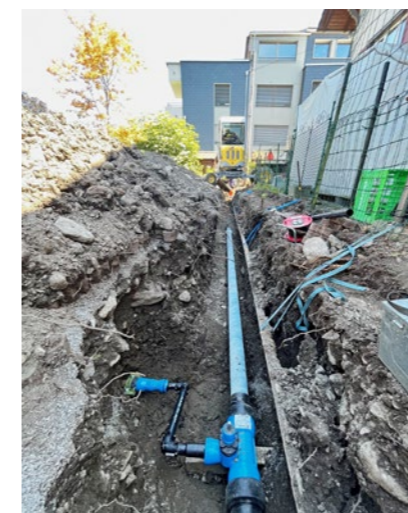
Sanierungsarbeiten am Wasserleitungsnetz
