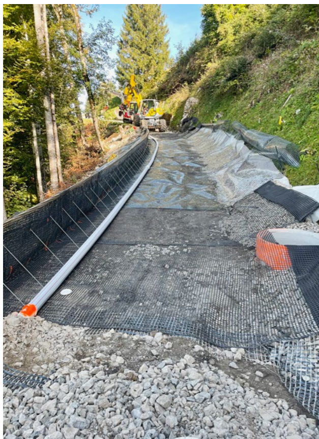
Sanierungsarbeiten an der Ischenstrasse
