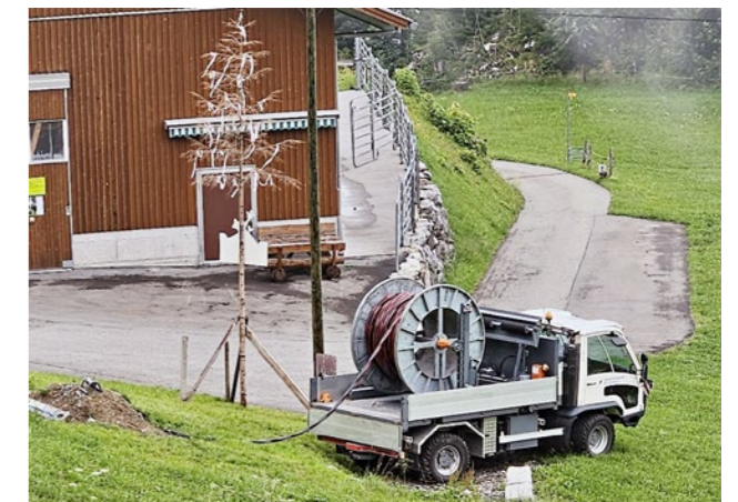
Das neue Stromkabel wird verlegt
