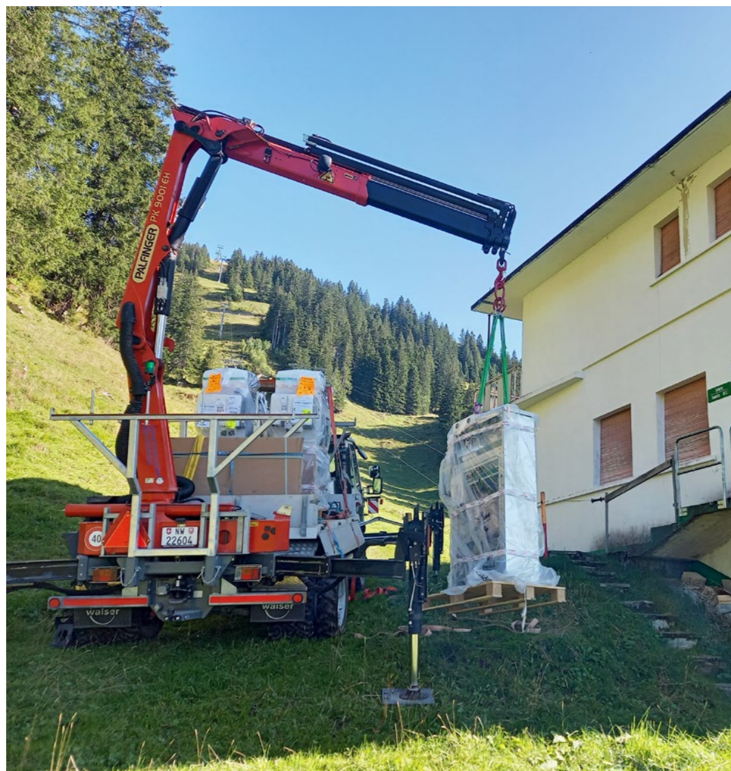
Anlieferung der neuen Schaltanlage in der Wangi
