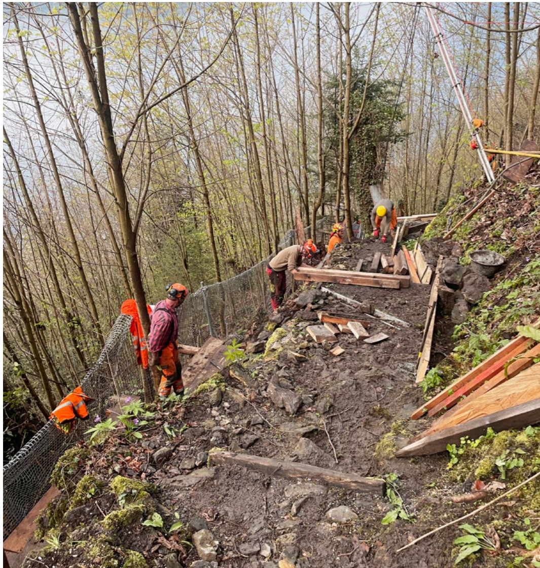
Instandstellung Jakobsweg im Abschnitt Rütene Richtung Emmetten
